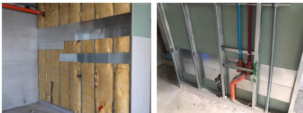
照片一 加強鐵片補強
